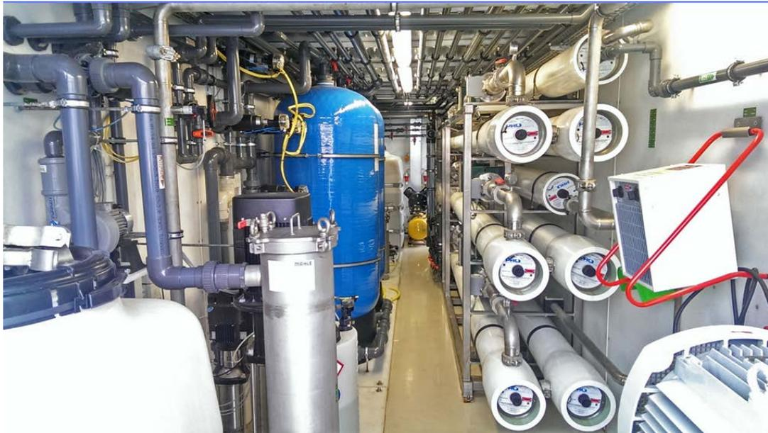
Рис. 5 - Внешний вид контейнерной Установки обратного осмоса по очистке фильтрата полигона
